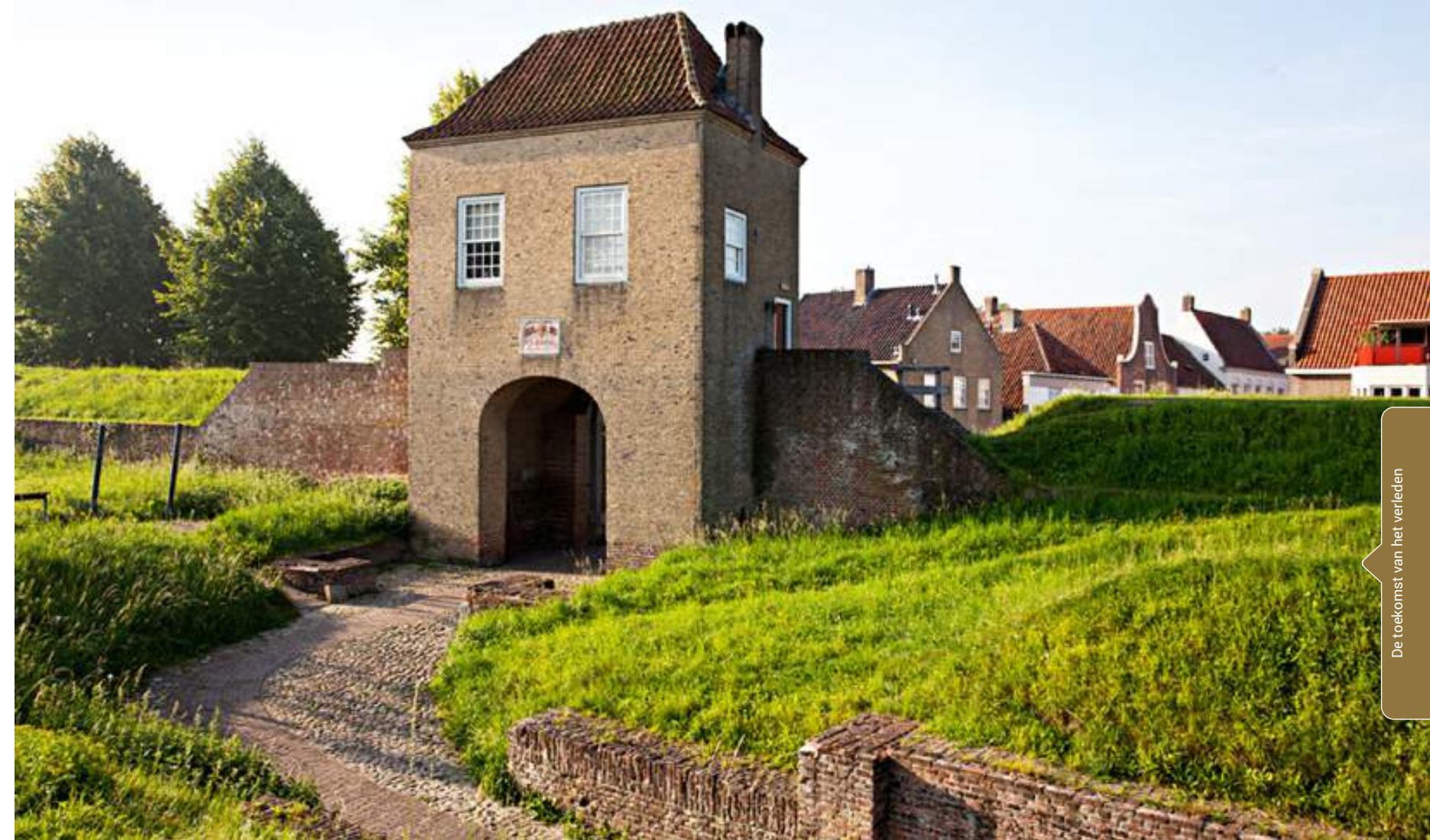
Een gerenoveerde stadspoort in Heusden. Bron: Lieske Meima, 2018.
