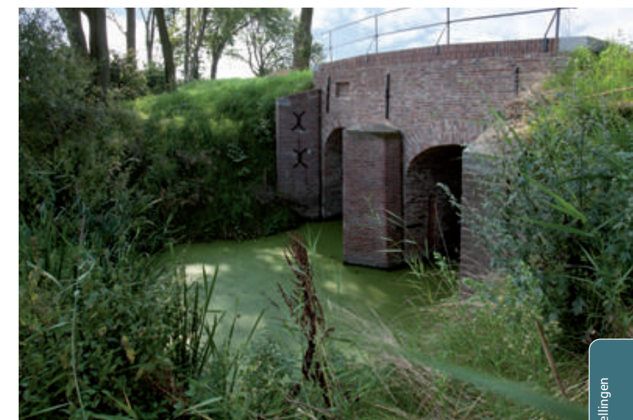
Een sluis in de Elshoutse Zeedijk. Bron: Lieske Meima, 2018.
