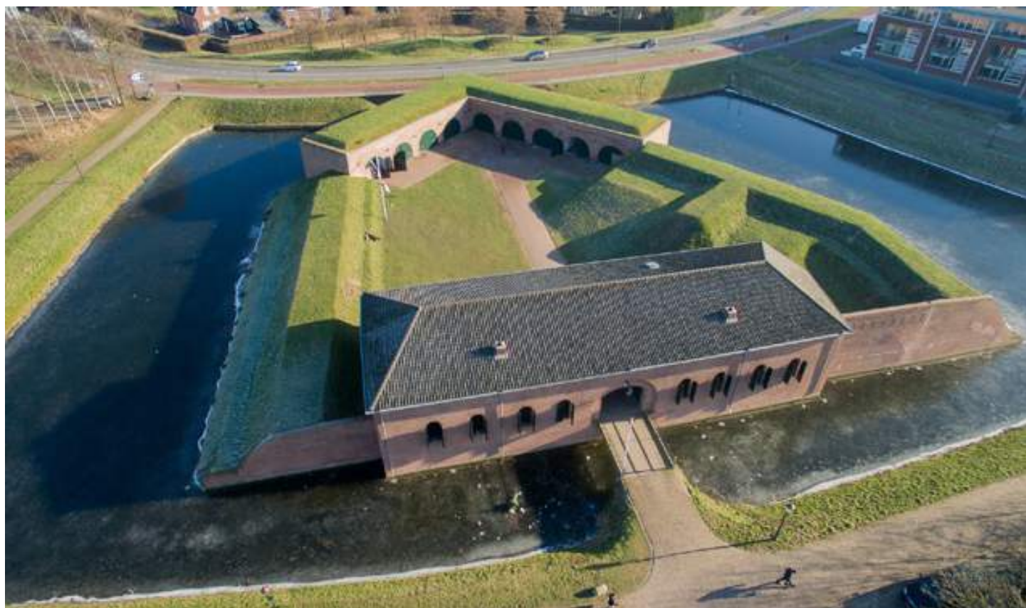
Lunet aan de Donge in Geertruidenberg onderging eind 2013 een ingrijpende renovatie. De loopbrug is in ere hersteld. Bron: www.bndestem.nl, 2015.
